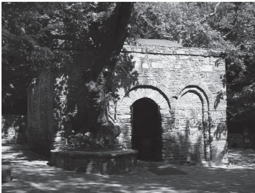
Restos de la casa que fuera de los padres de María, en Séforis.
